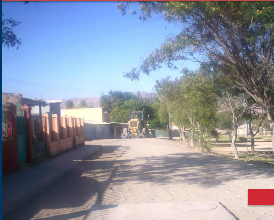
CALLE SIN PAVIMENTO
